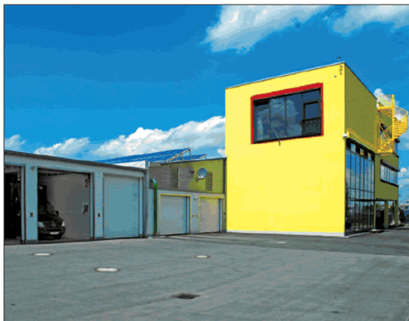
Außenansicht des Bürogebäudes und eines Teils des Versandbereichs; in den (zu Anschauungszwecken geöffneten) Garagen sieht man die Thermokoffer-Laster.
