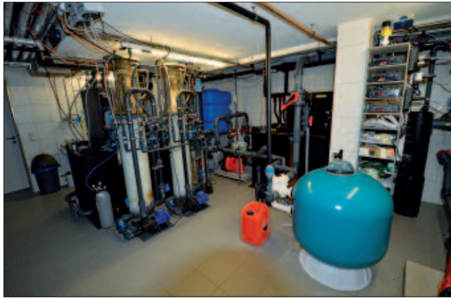
Oben links: Blick auf die Filteranlagen und Abschäumer für den Meerwasserteil
